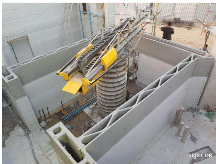
Obr. 2: Tisk největší budovy na světě v Dubaji společnosti Apis Cor. Zdroj: [4]
